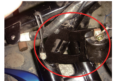
6. 高壓線圈固定座安裝位置 6.PLACE FOR INSTALLING HIGH TENSION COIL BRACKET.
