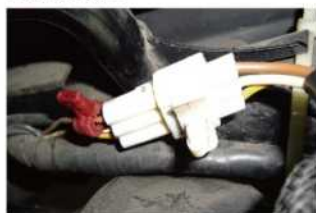
7.將接線夾夾上電盤訊號線(咖啡色)
